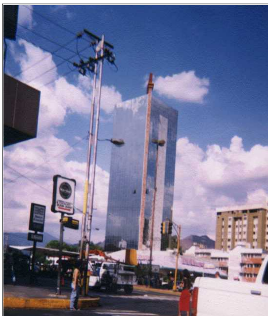
TORRE DE OFICINA COMERCIAL
